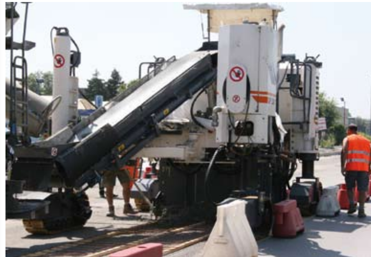
SP 250 con nastro trasportatore del calcestruzzo, lunghezza 6,00 m Dimensioni in mm
